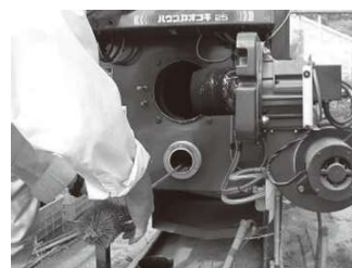
※点検整備の前には必ず電源を切り、燃料バルブを閉めること!
