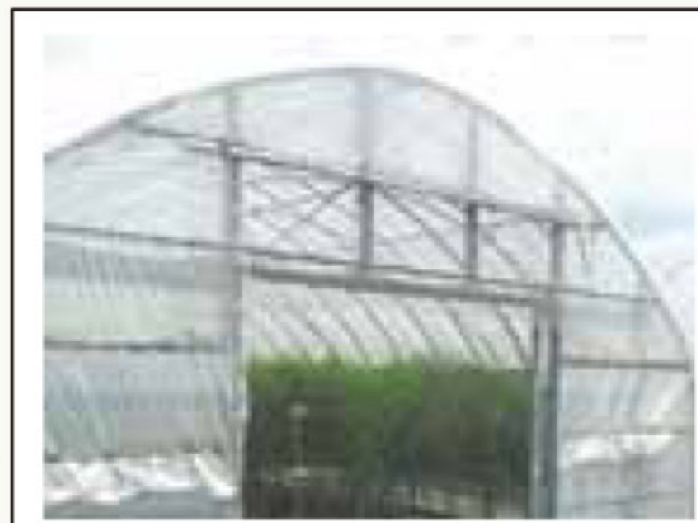
ビニルを直管で巻き上げてヒモで縛る事例
