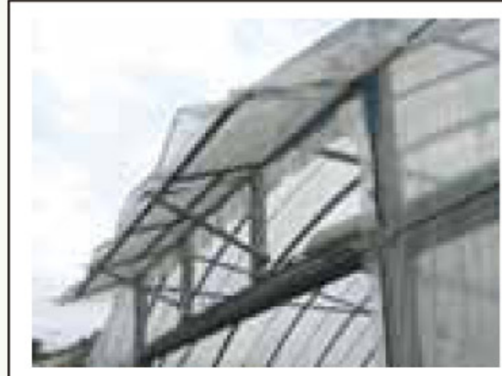
農家自作の妻面換気窓の事例
