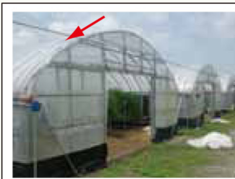
4連棟を巻き上げ機（矢印）でビニルを直管で巻き上げる事例
