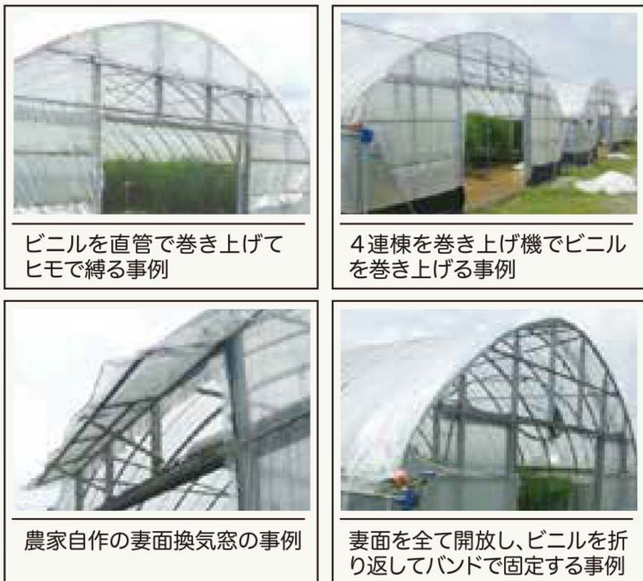
図2 妻換気の工夫事例
