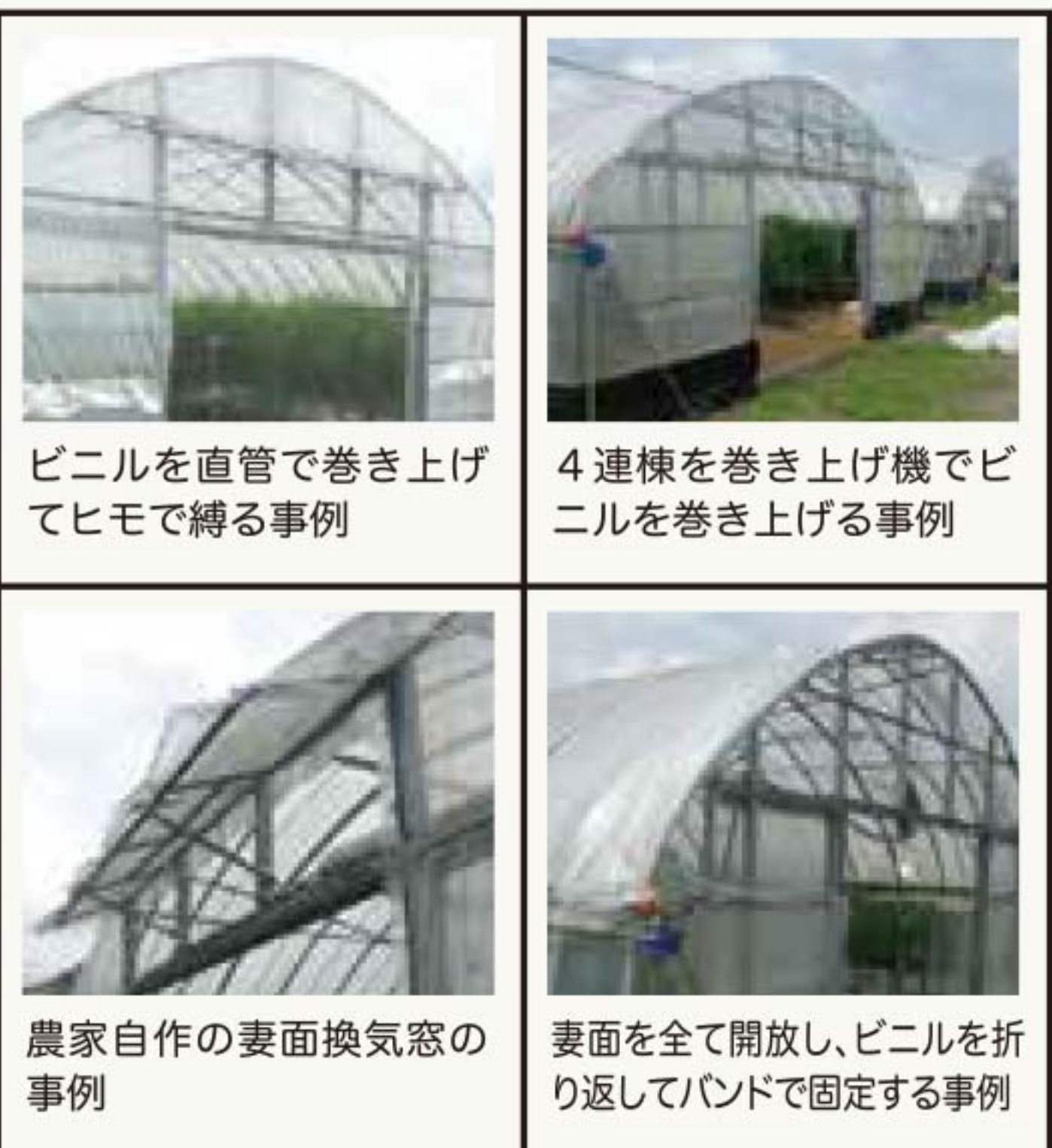
図2 妻換気の工夫事例
